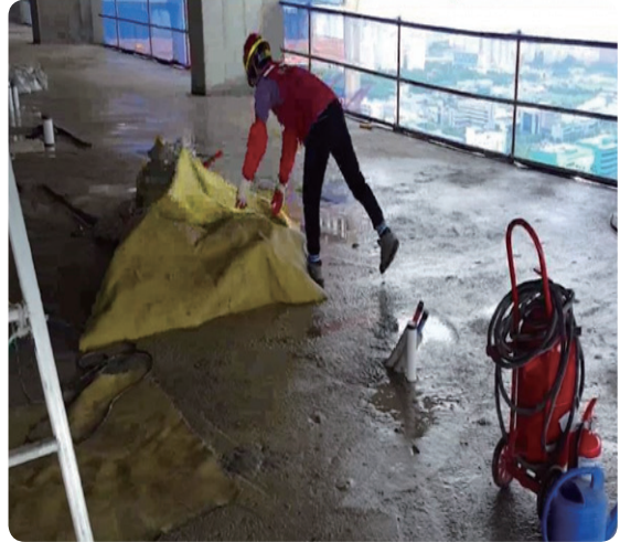
| 작업상황에 따라 방화 방지포를 덮어 방호 |
