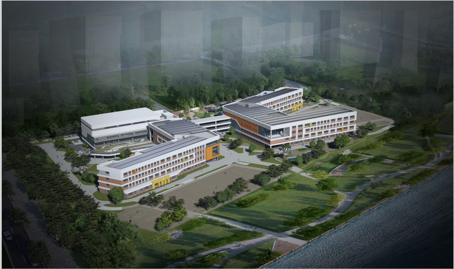
시화MTV 초중통합학교 건축공사
