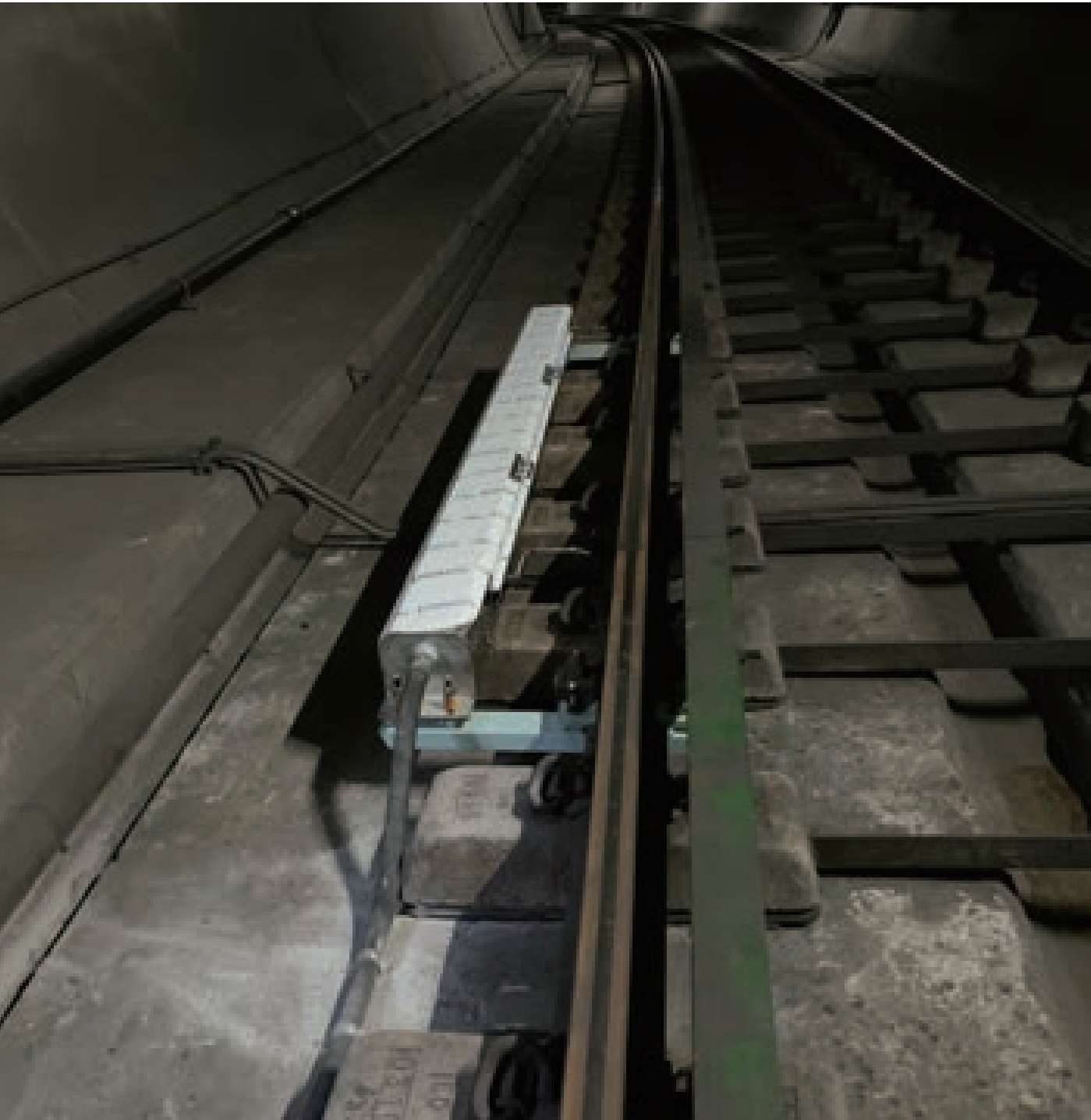
▲ 레일코팅시스템 설치 전경
